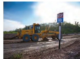
Pengerasan jalan pengangkutan untuk keamanan dan efisiensi
